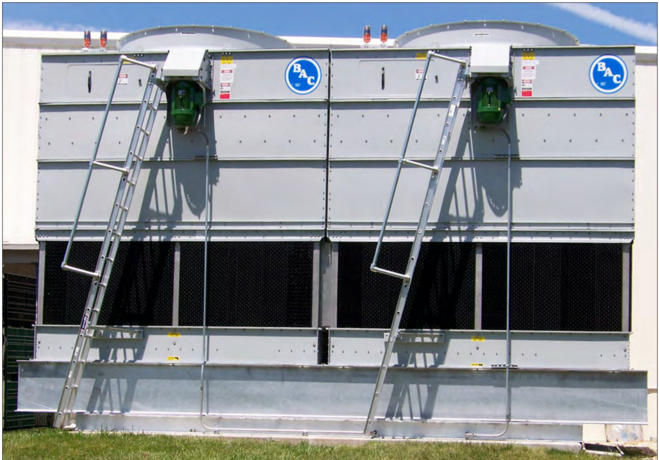
Instalación de PT2 de dos celdas
