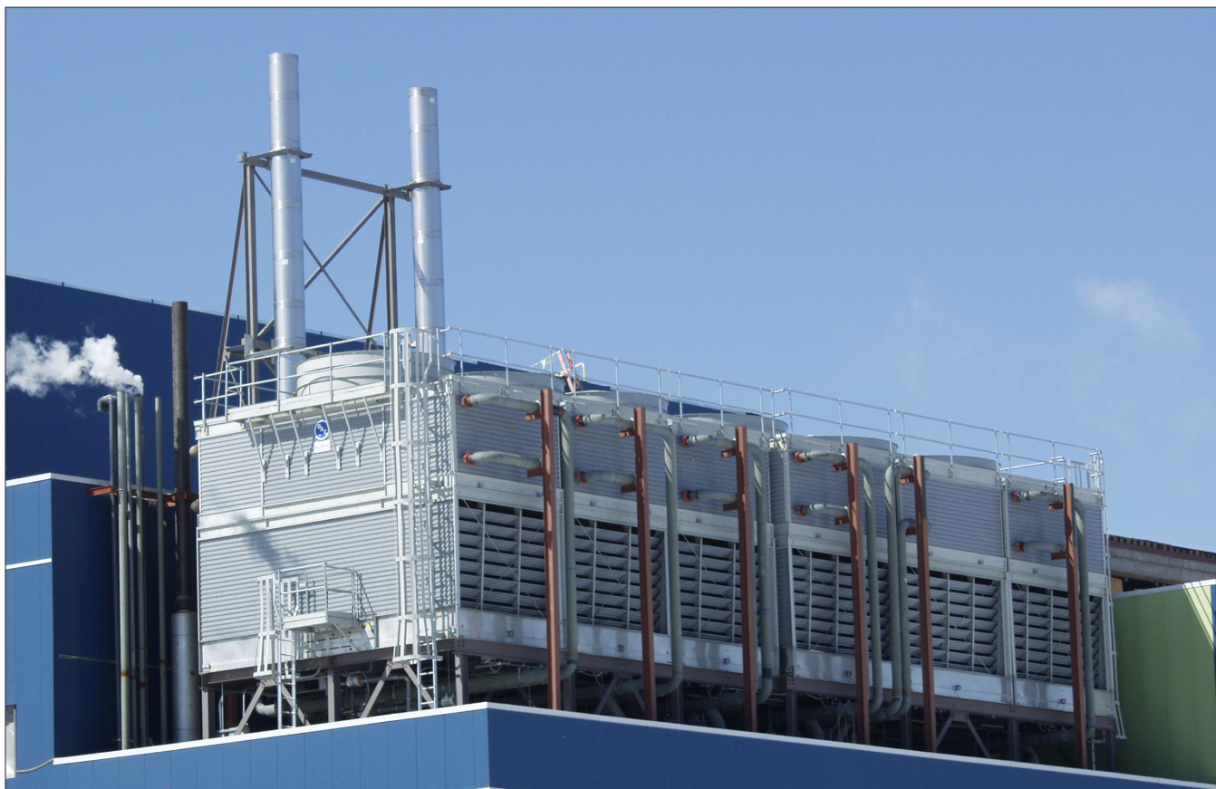
Instalación de FXV de doble entrada de aire, multi-celda
