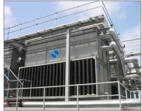
FXV con Atenuador de Sonido en la entrada
