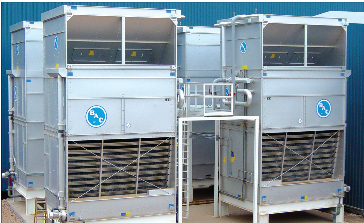
Instalación de HXV multi-celda
